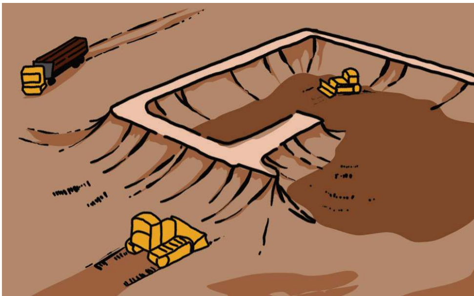
Gambar 5.12 Pembuatan Kolam Cadangan atau Mud Pit
