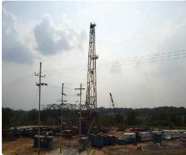
Gambar 6.10 Pekerjaan Penyelesaian Akhir Sumber: PPSDM Migas Cepu/Susilo (2012)
