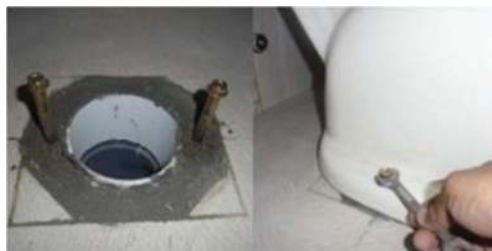
Pemasangan baut disesuaikan dengan tipe kloset
