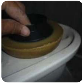
Pemasangan wax ring
