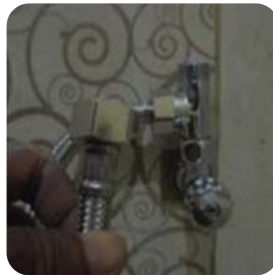
Pemasangan stop keran, T dan flexible hose
