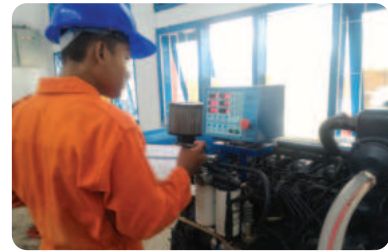
Gambar 3.10 Teknisi perawatan dan perbaikan mesin kapal sumber: Dudi Rachadi/Kemendikbudristek (2024)
