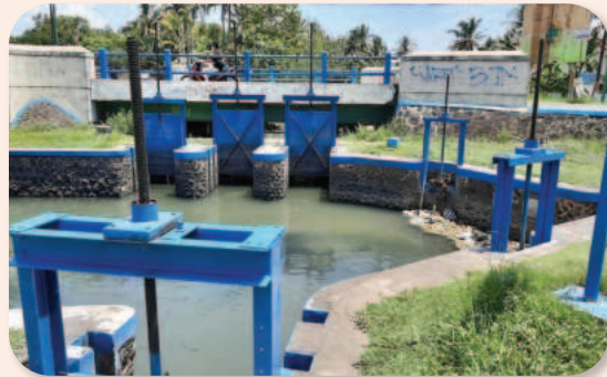
Gambar 4.5 Bangunan pembagi air pada saluran irigasi.
