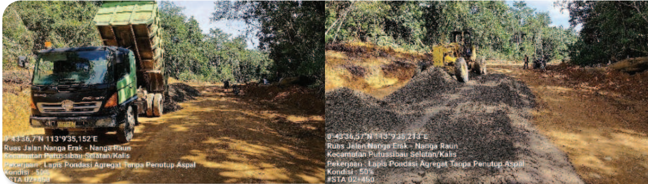
Gambar 6.6 Pekerjaan Konstruksi Lapisan Fondasi (Ruas jalan Nanga Erak-Nangan Raun) Kec. Putussibau Selatan
