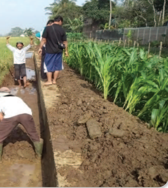
Gambar 4.17 Pekerjaan Tanah dalam Pembangunan Saluran Irigasi
