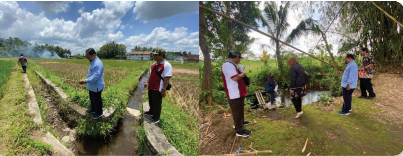
Gambar 1.11 Pengukuran dan Survei Lokasi Pembangunan Talud dan Irigasi
