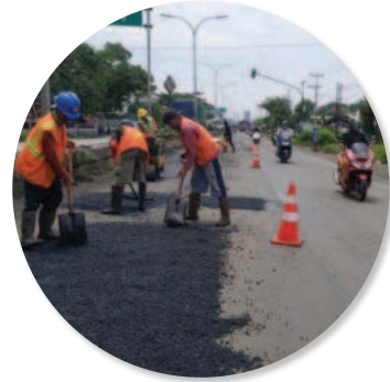
Gambar 3.14 Penambalan Jalan dengan Aspal hotmix
