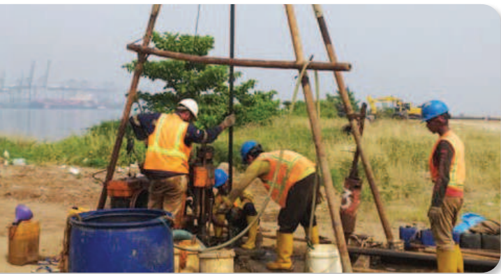
Gambar 1.20 Pengeboran Tanah
