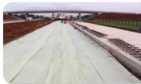
Gambar 3.7 Pemasangan Plastik Sheet
