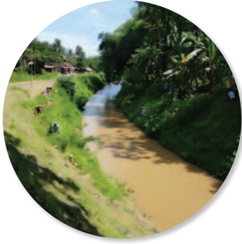
Gambar 4.24 Pekerjaan Pembersihan Saluran Irigasi
