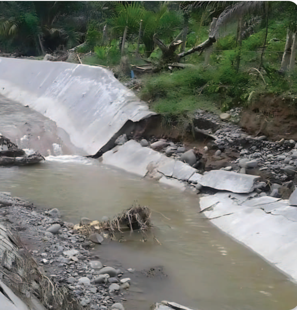
Gambar 4.4 Rusaknya Irigasi di Siantar
