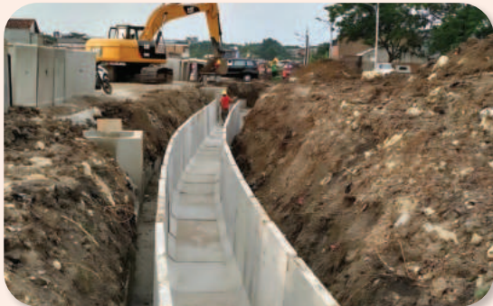
Gambar 4.26 Saluran irigasi menggunakan box U-Ditch .
