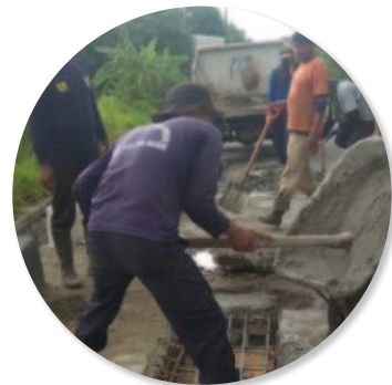
Gambar 3.15 Pekerjaan Bahu Jalan
