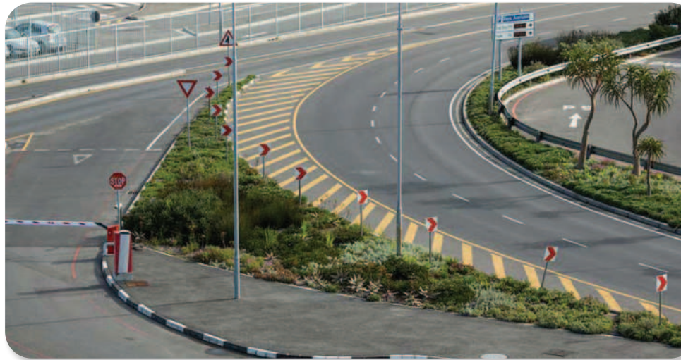
Gambar 6.11 Markah Jalan dan Rambu Lalu Lintas
