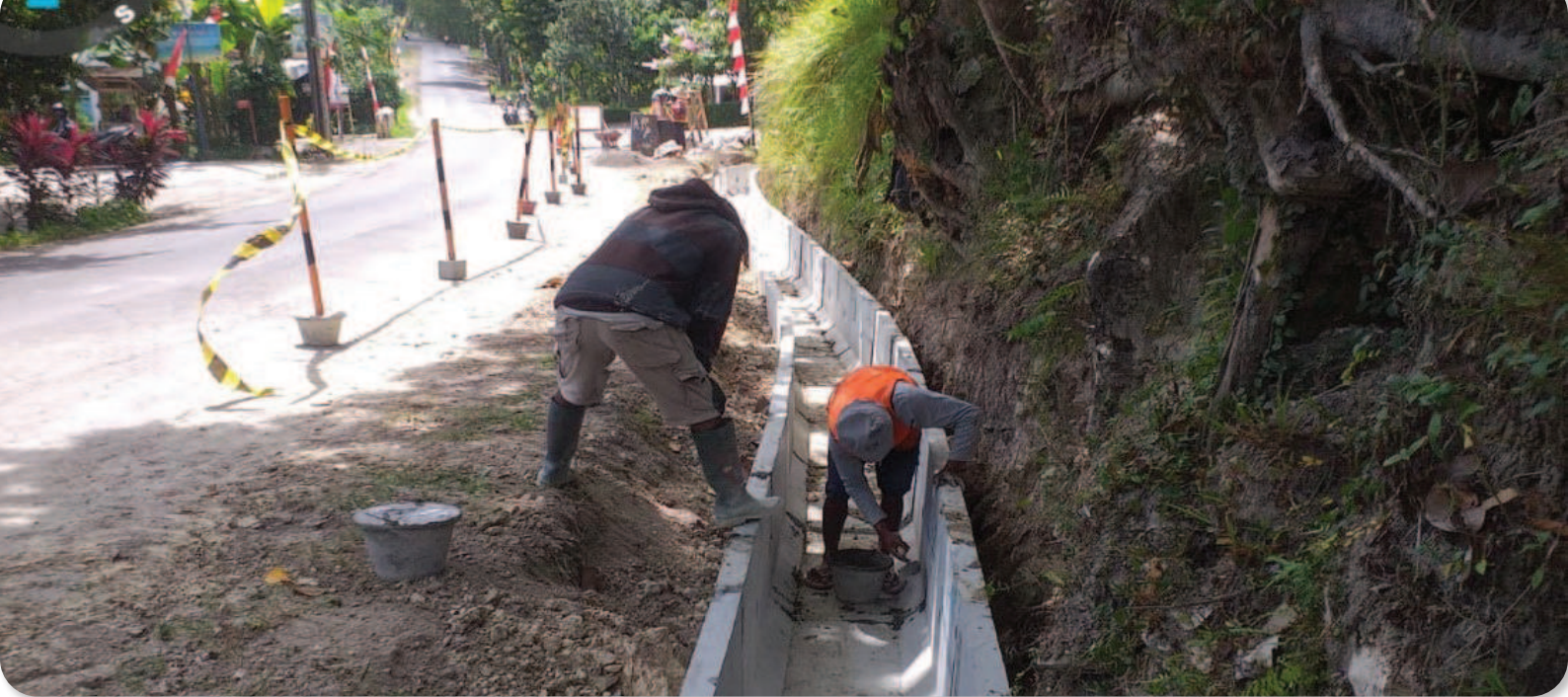
Gambar 3.5 Pekerjaan Drainase Jalan
