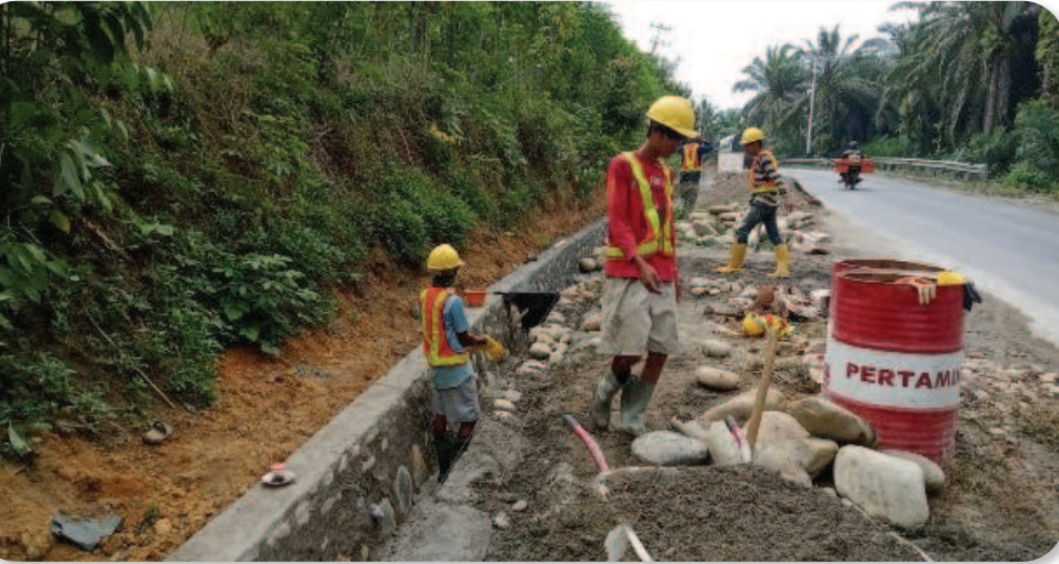
Gambar 6.9 Pekerjaan Drainase Jalan
