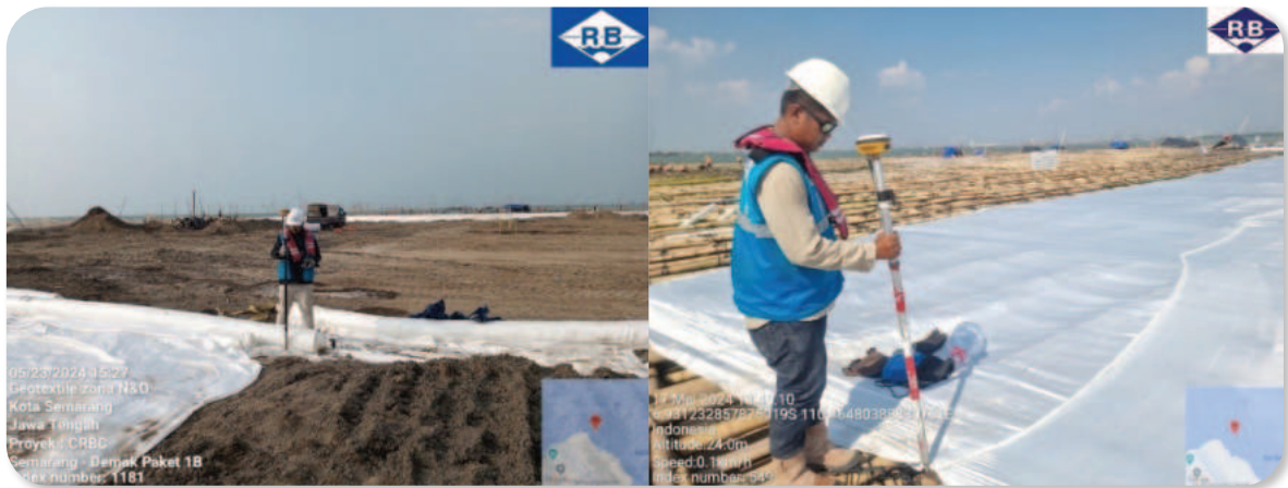
Gambar 1.7 Staking out Pekerjaan Jalan Tol Semarang-Demak Paket 1B
