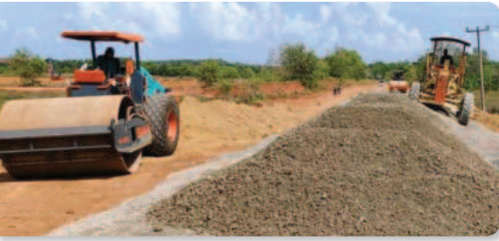
Gambar 3.6 Pekerjaan Fondasi Jalan, di Jalan Daeng Celak, Kota Tanjungpinang
