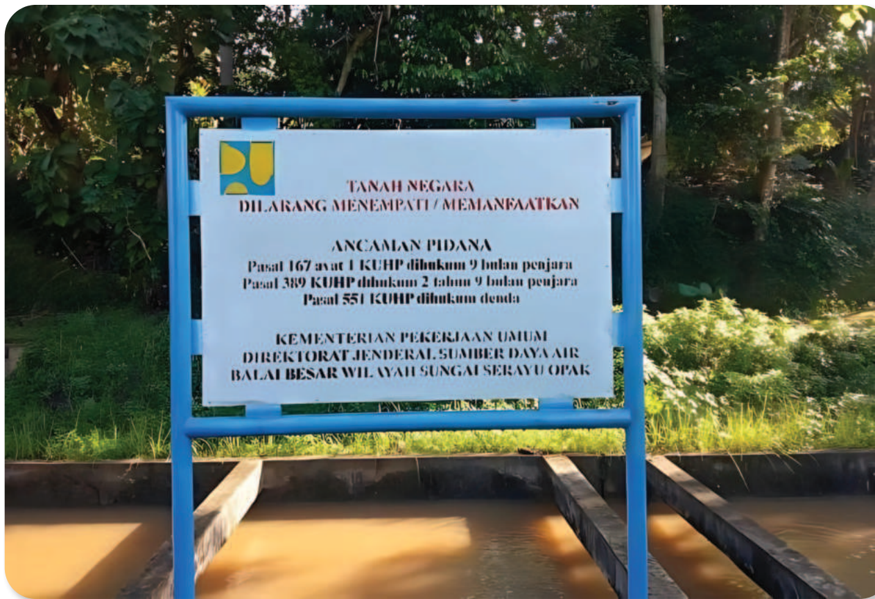
Gambar 4.23 Pemasangan Papan Larangan
