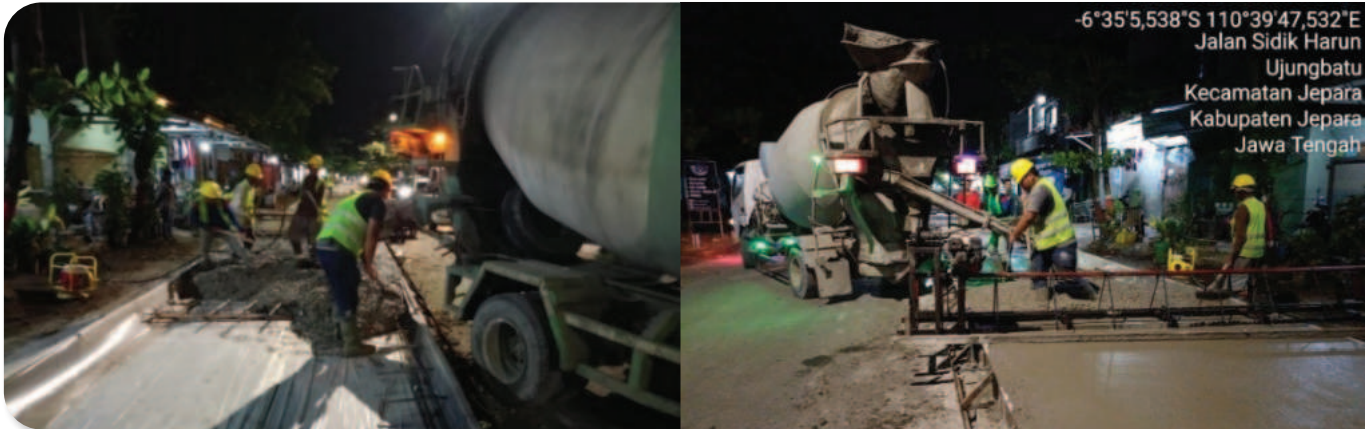
Gambar 3.10 Pengecoran Beton
