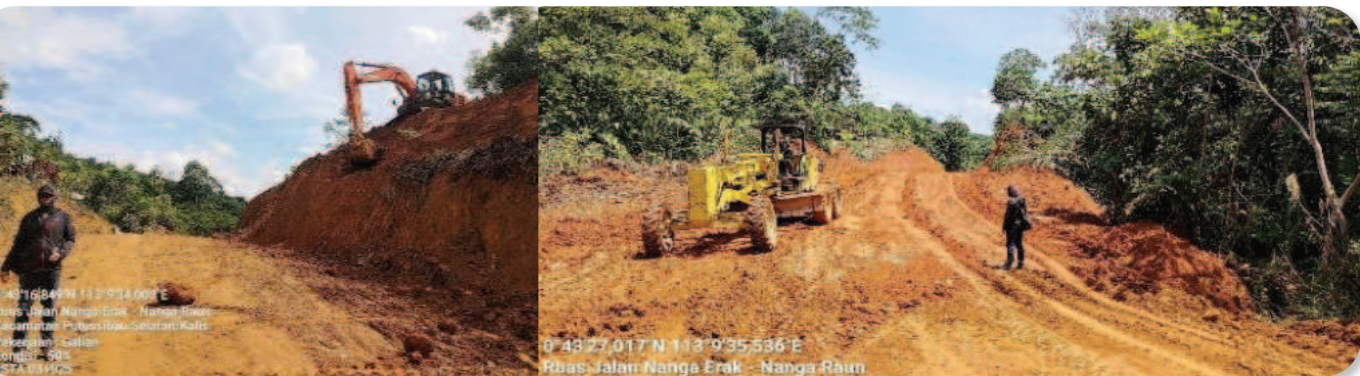
Gambar 6.5 Pekerjaan Penggalian Tanah (Ruas jalan Nanga Erak-Nangan Raun) Kec. Putussibau Selatan
