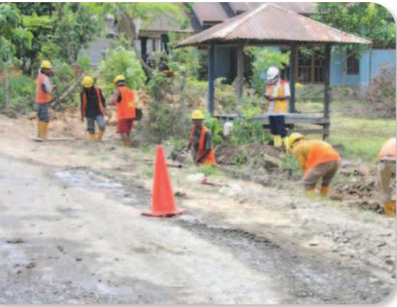
Gambar 6.3 Pekerjaan Pembersihan Area
