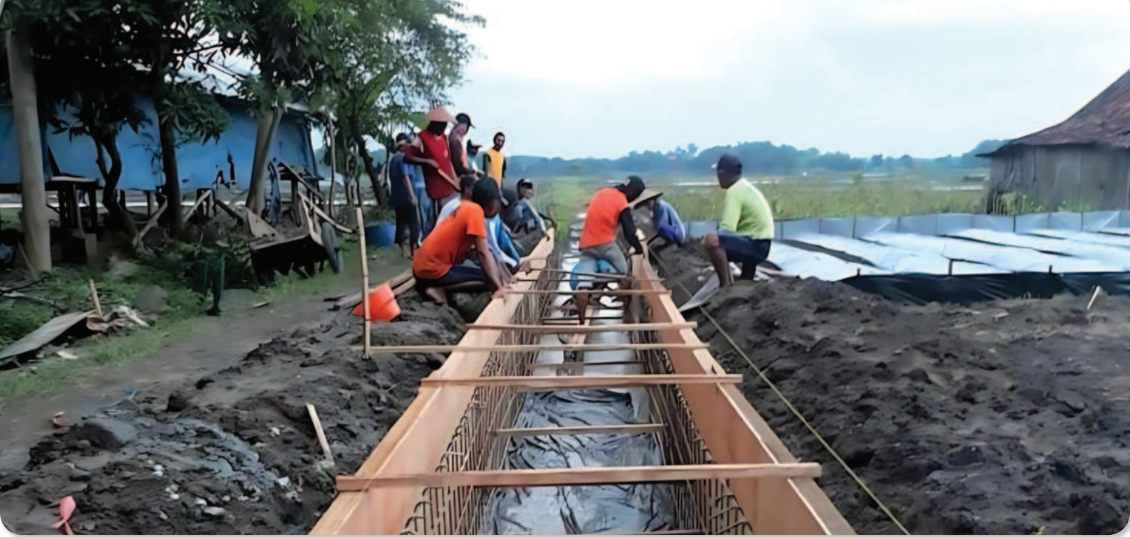
Gambar 4.18 Pekerjaan Pelapisan Beton dalam Pembangunan Saluran Irigasi
