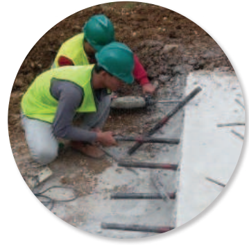
Gambar 3.8 Pemasangan Dowel
