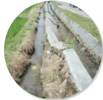
Gambar 4.4 Rusaknya Irigasi di Siantar
