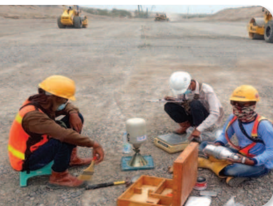
Gambar 3.4 Pekerjaan Pemasangan Tanah
