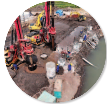
Gambar 6.16 Pemasangan Bore Pile Jembatan Pandansimo
