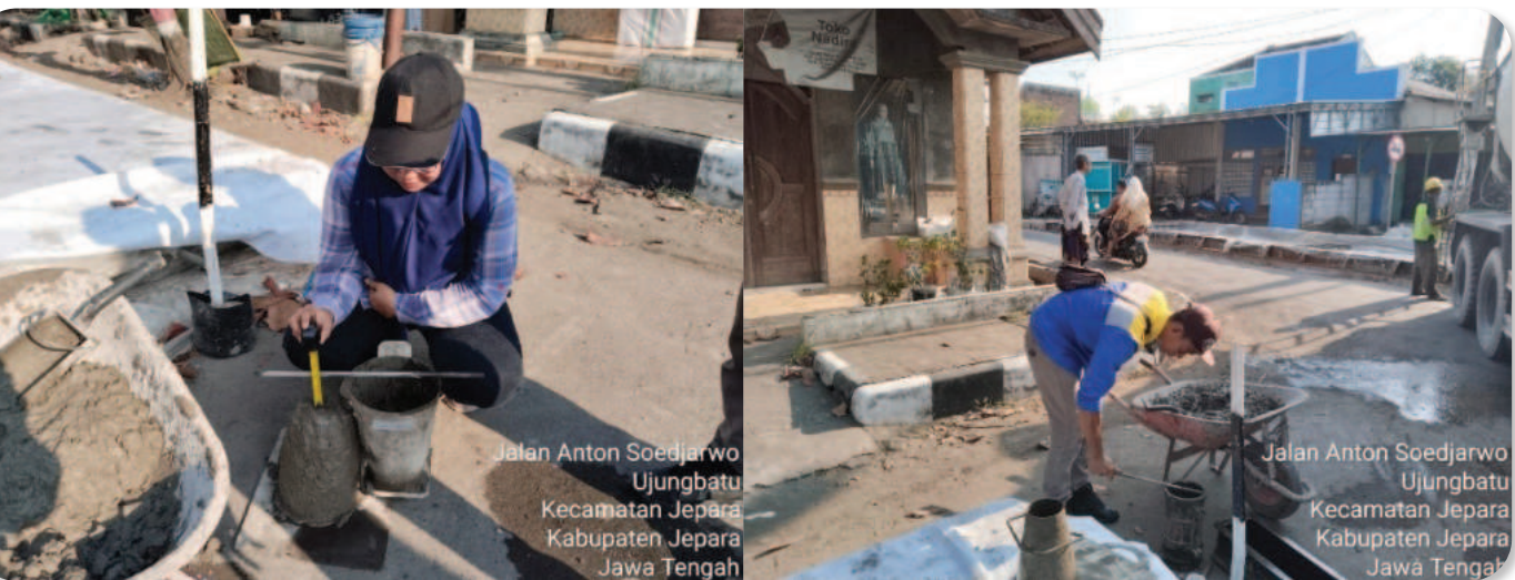
Gambar 3.9 Uji Slump dan Lean Concrete Pekerjaan Jalan di Kec. Jepara
