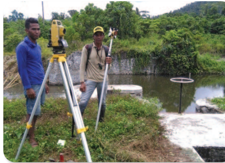
Gambar 1.13 Pengukuran dan Survei Lokasi Pembangunan Talud dan Irigasi
