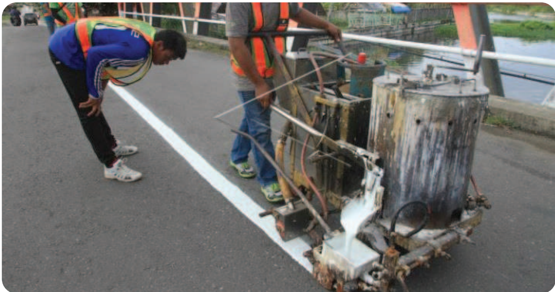
Gambar 3.17 Pekerjaan Pengecatan Markah Jalan di Aceh Barat
