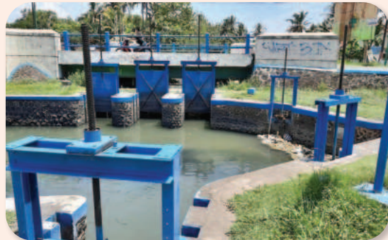
Gambar 4.27 Bangunan pembagi air pada saluran irigasi.
