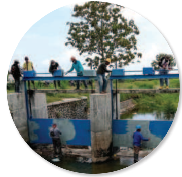
Gambar 4.25 Pekerjaan Pengecatan Pintu Air
