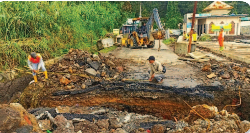
Gambar 6.10 Pekerjaan Gorong-gorong Ruas Rake-Sanjaya Kab. Wonosobo
