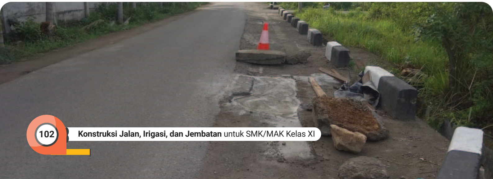
Gambar 3.15 Pekerjaan Bahu Jalan
