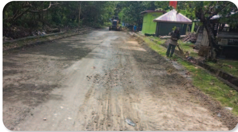
Gambar 6.4 Pekerjaan Persiapan Jalan
