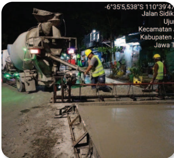
Gambar 6.7 Pekerjaan Konstruksi Lapisan Permukaan (Jalan Beton)
