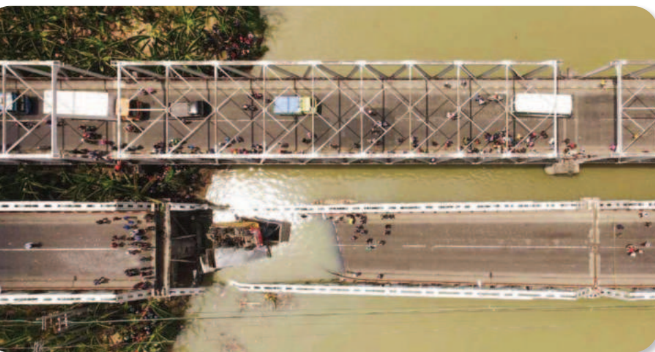
Gambar 5.1 Jembatan Widang penghubung Tuban-Lamongan yang runtuh
