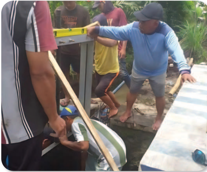
Gambar 4.19 Pekerjaan Pembangunan Pintu Air pada Saluran Irigasi
