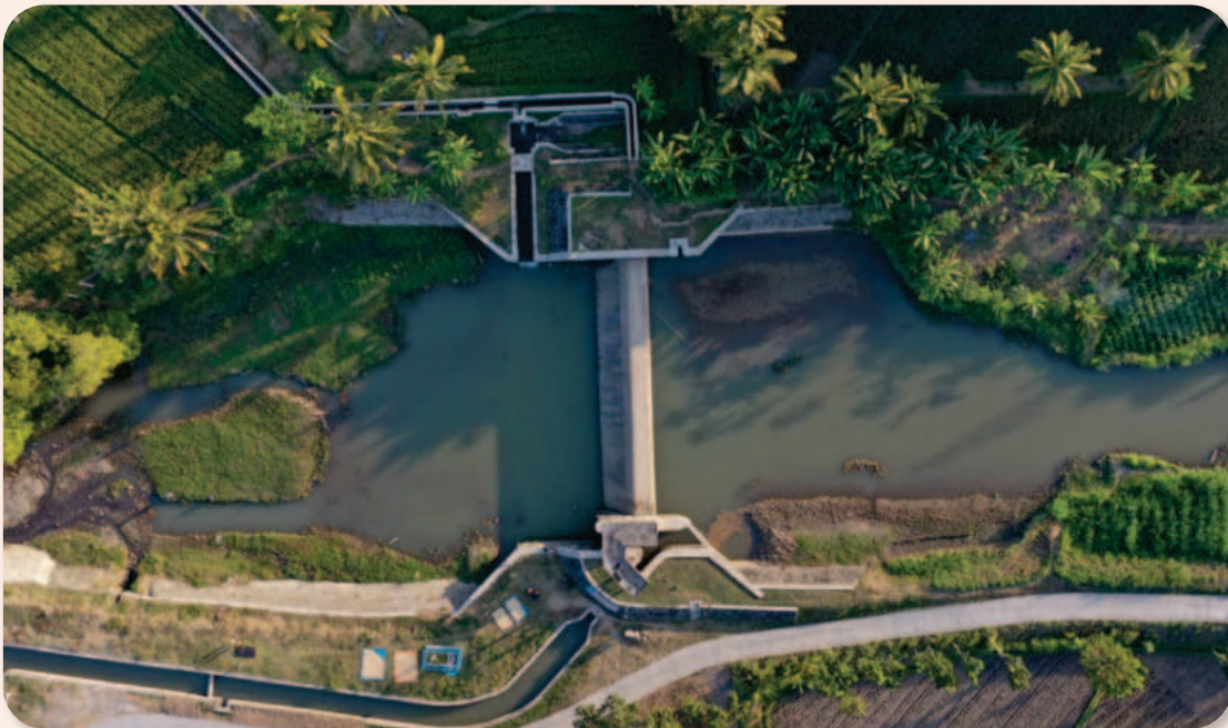
Gambar 4.16 Bangunan Utama Irigasi
