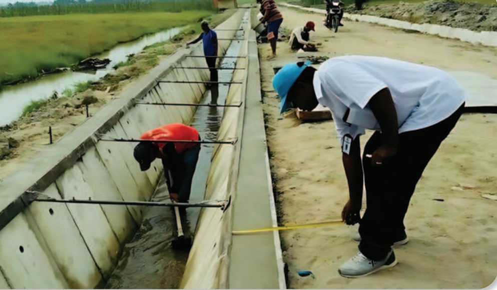
Gambar 4.21 Pekerjaan pengecekan ukuran pembangunan saluran irigasi oleh pihak terkait.
