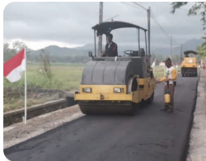
Gambar 6.8 Pekerjaan Konstruksi Lapisan Permukaan (Jalan Aspal)
