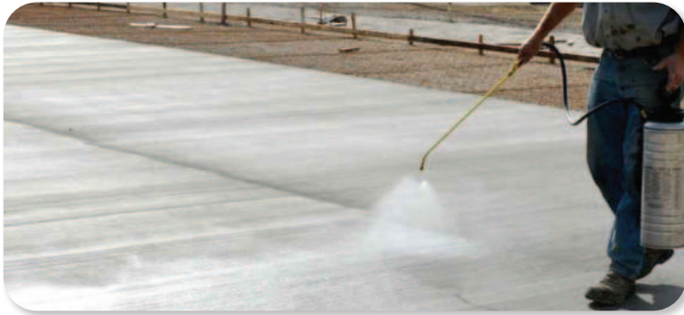
Gambar 3.11 Pemasangan Curing Beton
