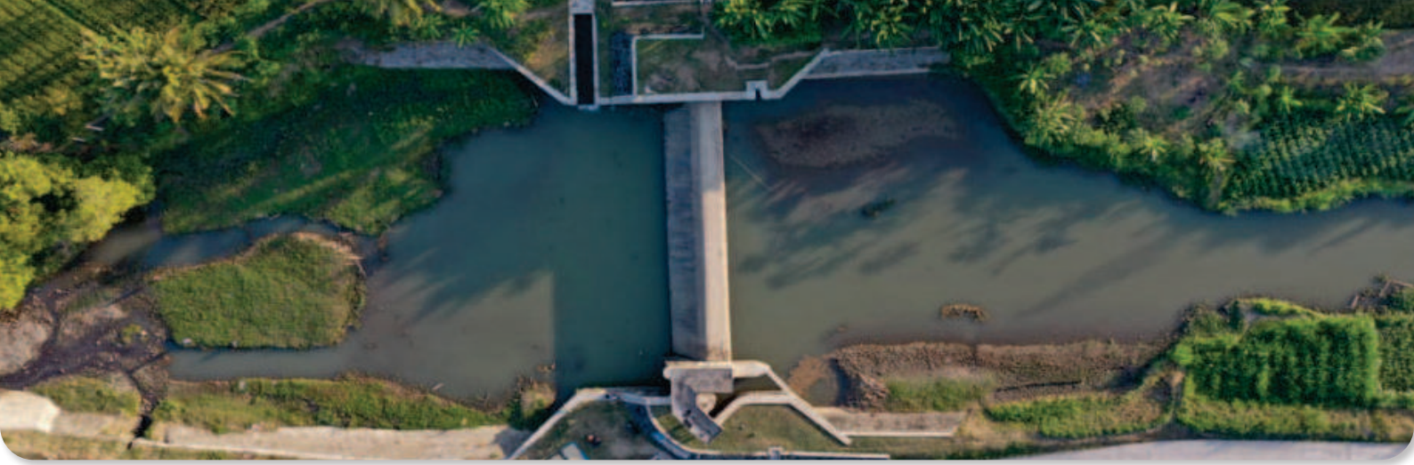
Gambar 2.10 Bangunan Utama Irigasi
