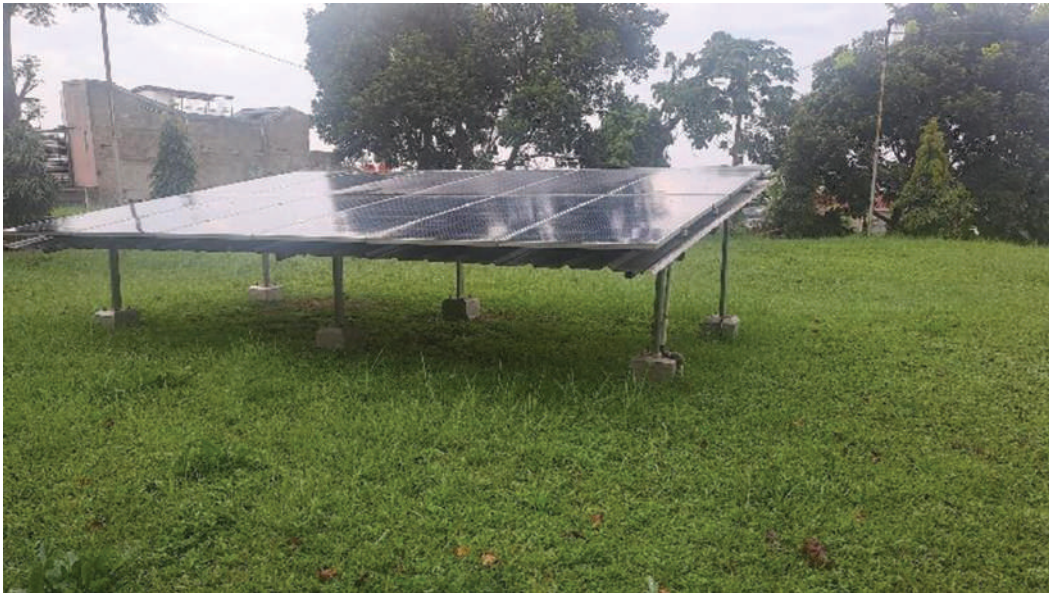
Gambar 1.45 PLTS di Atas Tanah
