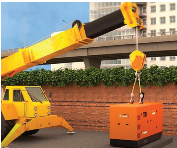
Gambar 4.39 Penempatan Genset dengan Crane Mobile
