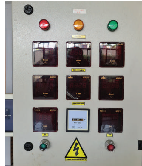
Gambar 2.19 Sistem Monitoring pada PLTMH Sumber: Zainul, Kemdikbudristek (2024)
