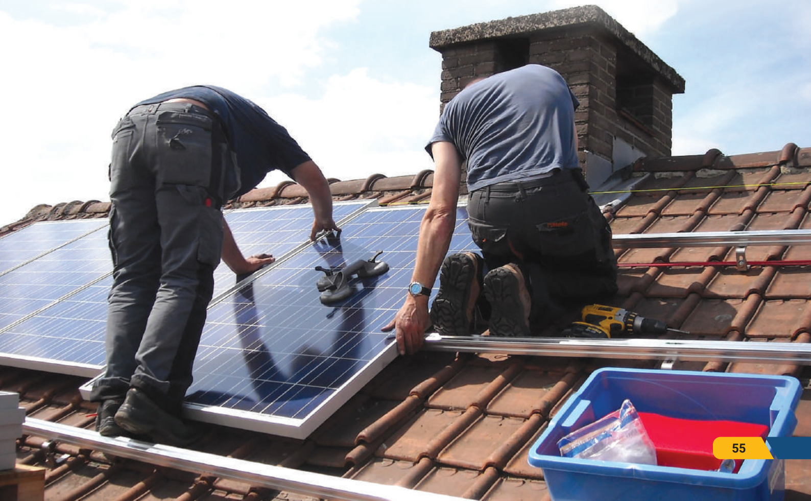
Gambar 1.44 Pemasangan PLTS di Atas Atap.
