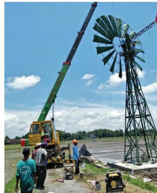
Gambar 4.42 Pemasangan Bagian Mekanik Turbin Angin Sumber: Amin Wahyono, Kemdikbudristek (2024)
