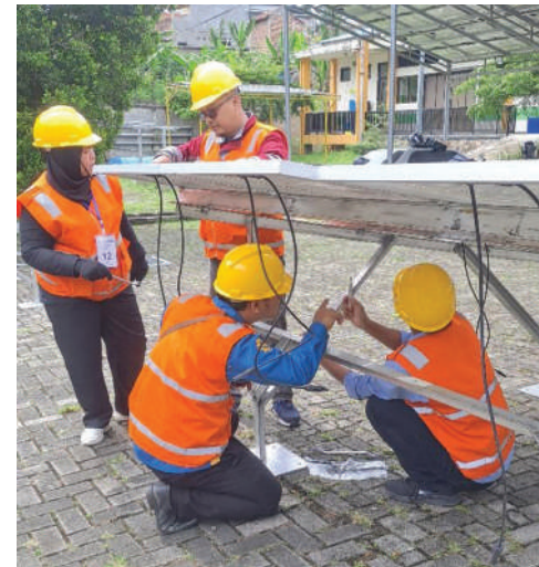
Gambar 1.52 Pemasangan Penopang Modul Surya
