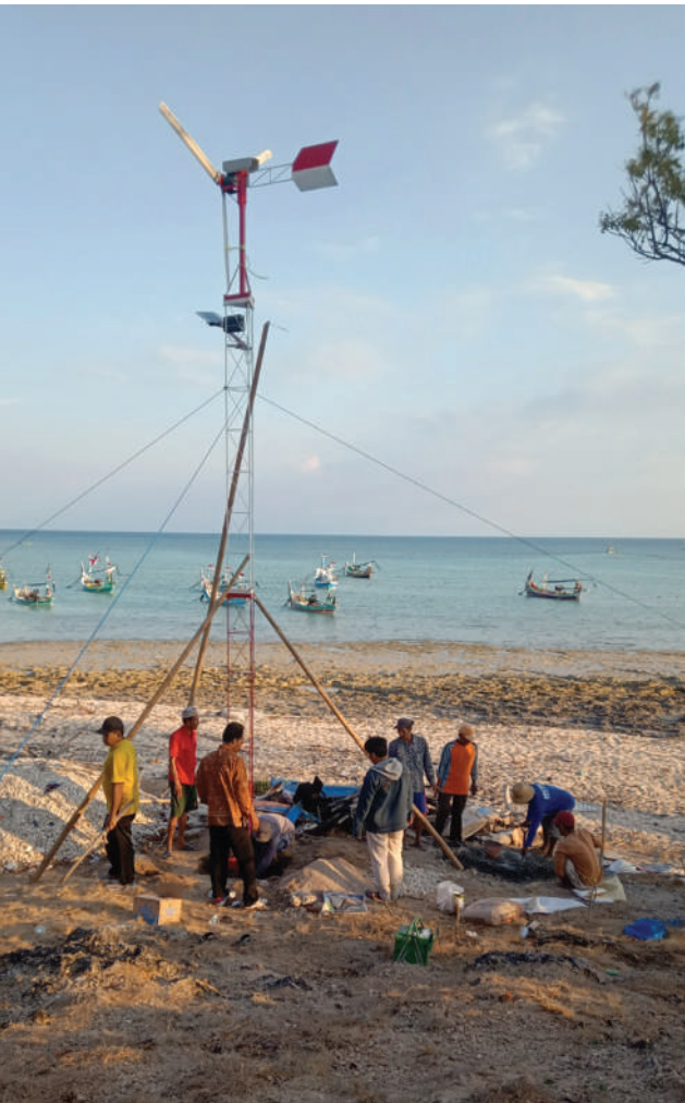
Gambar 3.3 Pemasangan PLTB di Pulau Mandangin Madura Jawa Timur Sumber: Amin Wahyono, Kemdikbudristek (2024)
