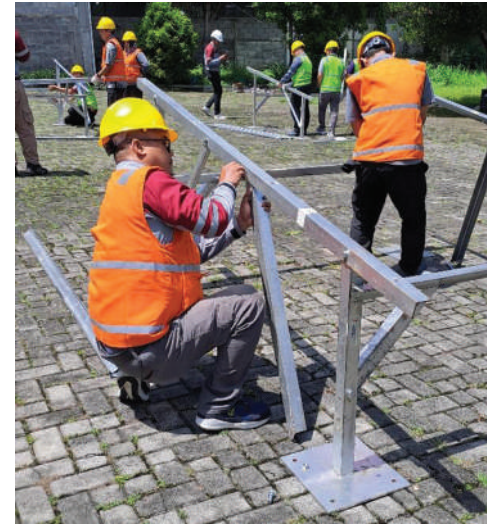
Gambar 1.51 Pemasangan Tiang Penopang
