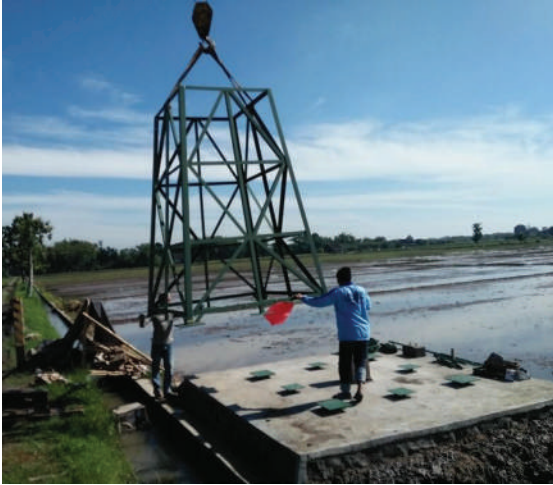
Gambar 4.40 Penempatan Koneksi Penyangga dan Fondasi Sumber: Amin Wahyono, Kemdikbudristek (2024)
