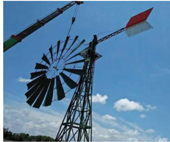
Gambar 4.41 Pemasangan Bilah Turbin Sumber: Amin Wahyono, Kemdikbudristek (2024)
