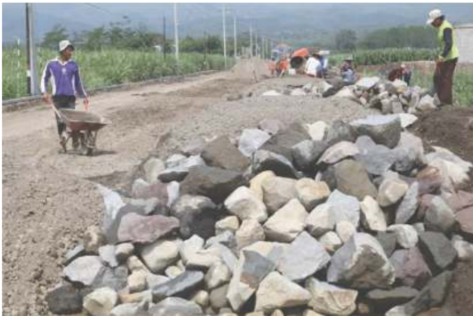
Gambar 5.8 Potret pembangunan infrastruktur jalan di daerah 3T.
