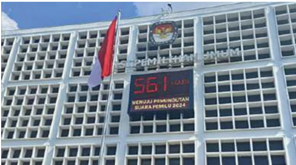
Gambar 3.6 Tampak depan gedung kantor Komisi Pemilihan Umum (KPU) Republik Indonesia, Jakarta.
