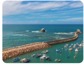
PEMBANGUNAN PEMECAH OMBAK
