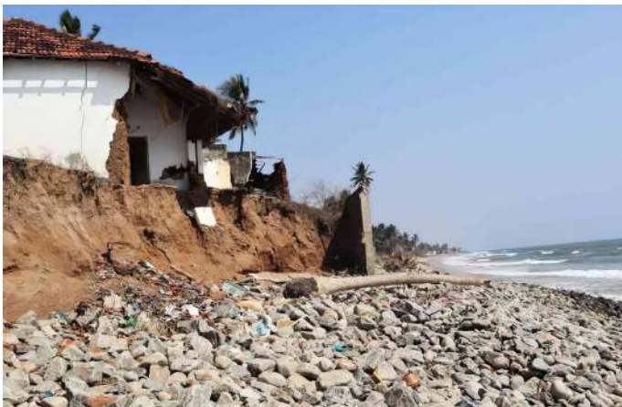
Contoh rumah-rumah yang hancur akibat erosi pantai. Sumber gambar: The News Minute
